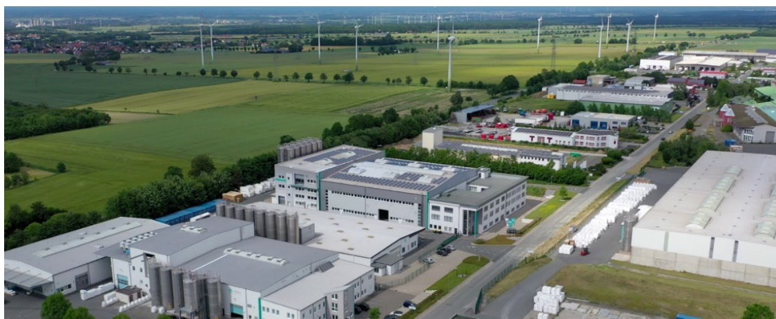
Abb. 5: Luftbildaufnahme des Gewerbegebiet Büren West 5
